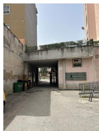
Foto n. 2 - Cortile interno del fabbricato dall'ingresso su strada
