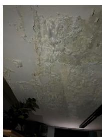
Foto n. 12 - Ambiente n. 1 - soffitto
