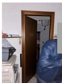
Foto n. 28 - Disimpegno verso il bagno
