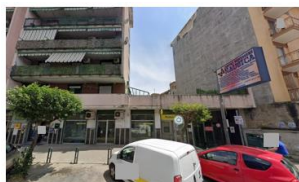
Foto n. 1 - Esterno del fabbricato in cui è ubicato l'immobile pignorato
